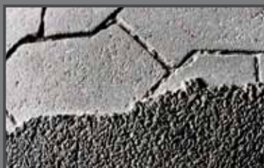
Belægning på SF-sten.
